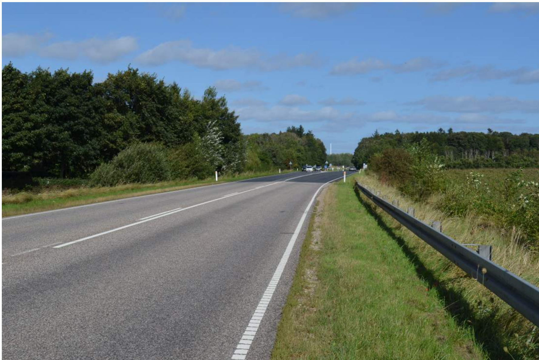
Figur 35 Landevejen set mod nord. Eksisterende forhold.
