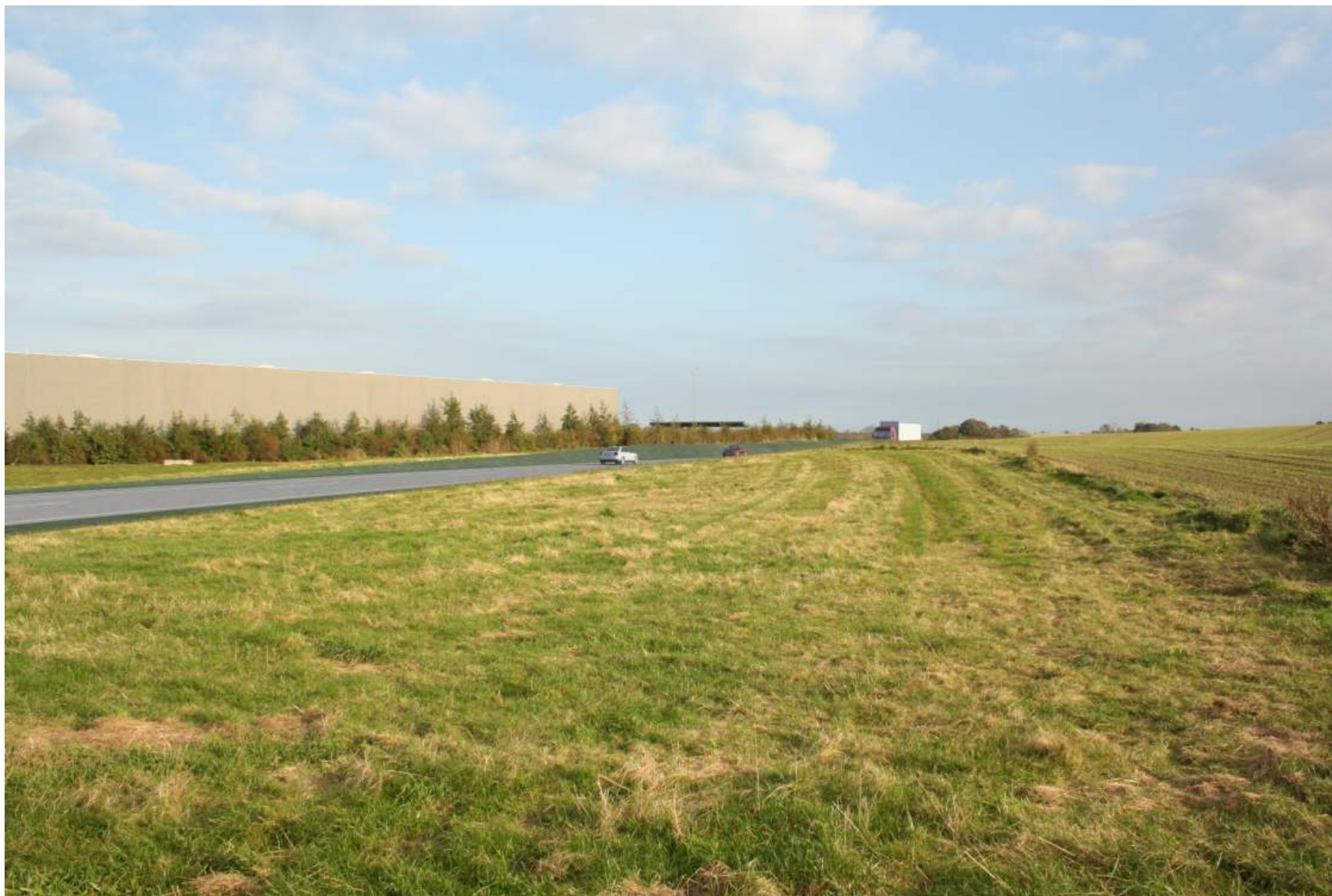
Figur 54 Visualisering af passagen ved Langhøj - alternativ A, B1 og C. Bering-Beder vejen er sænket i forhold til det eksisterende terræn. Afgravningen svækker opfattelsen af det lokale højdepunkt. Terrænvisualisering 4.
