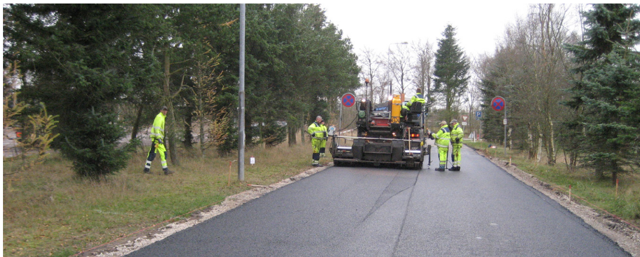
Figur 3.6: Udlægningen af drænasfalt på Eksportvej ved Billund i november 2012 (Foto NCC Roads).
