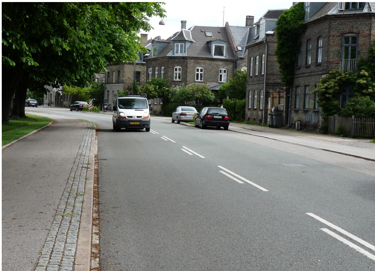
Figur 2.6: Forsøgsstrækningen med to-lags drænasfalt på Øster Søgade i København.
