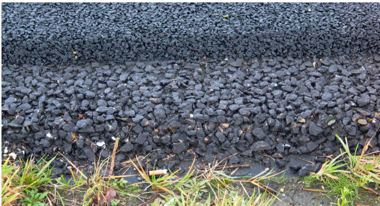
Figur 6.4: Nyudlagt to-lags drænasfalt med otte mm sten i toplaget set fra vejsiden på Hollandsk motorvej.
