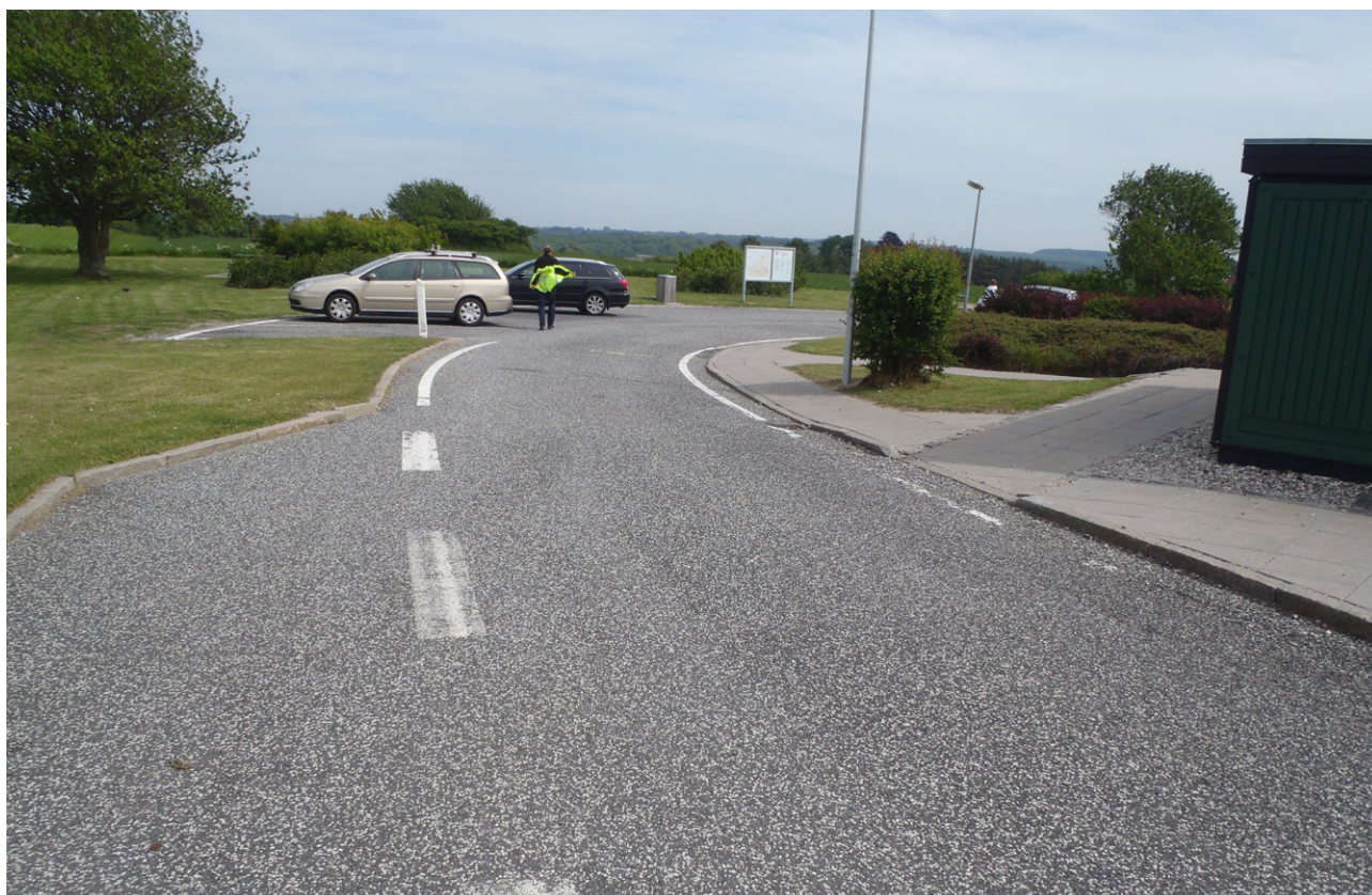
Figur 4.1: Rasteanlægget ved Arnakke, hvor der er udlagt en 25 m lang drænasfalt-belægning i august 2011.
