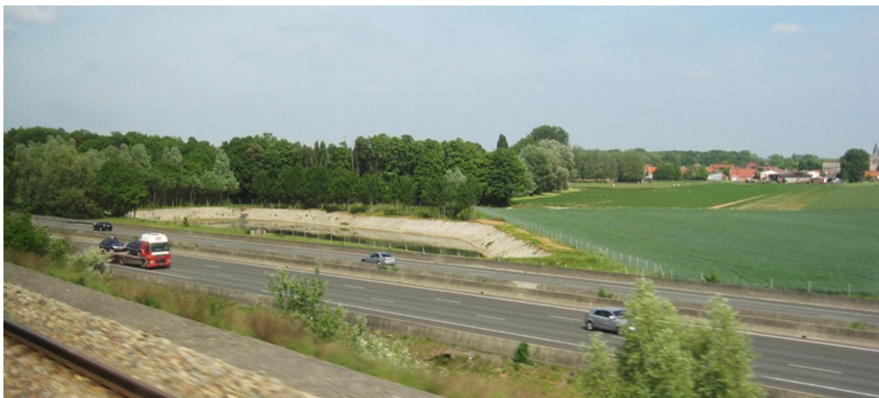
Figur 6.3: Drænasfalt er anvendt på en 200 km lang del af motorvej A1 nord for Paris.
