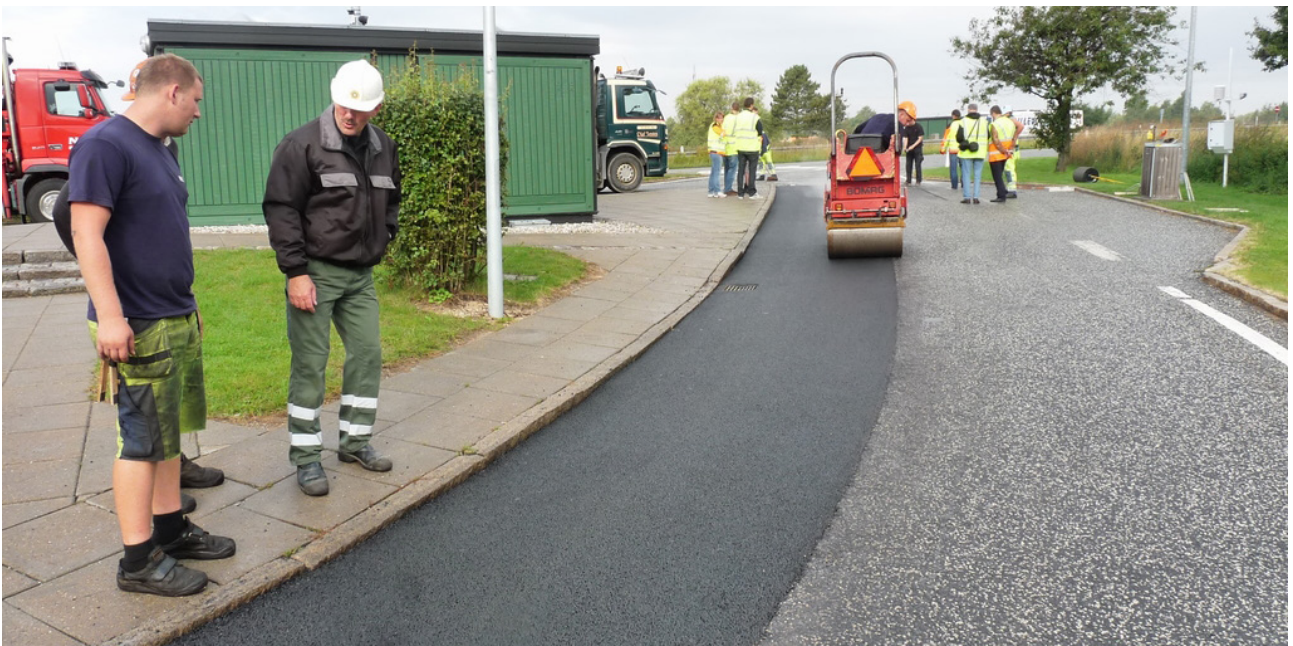
Figur 4.3: Udlægningen af DA 8-drænasfalt-belægningen ved Arnakke rasteanlægget i august 2011.
