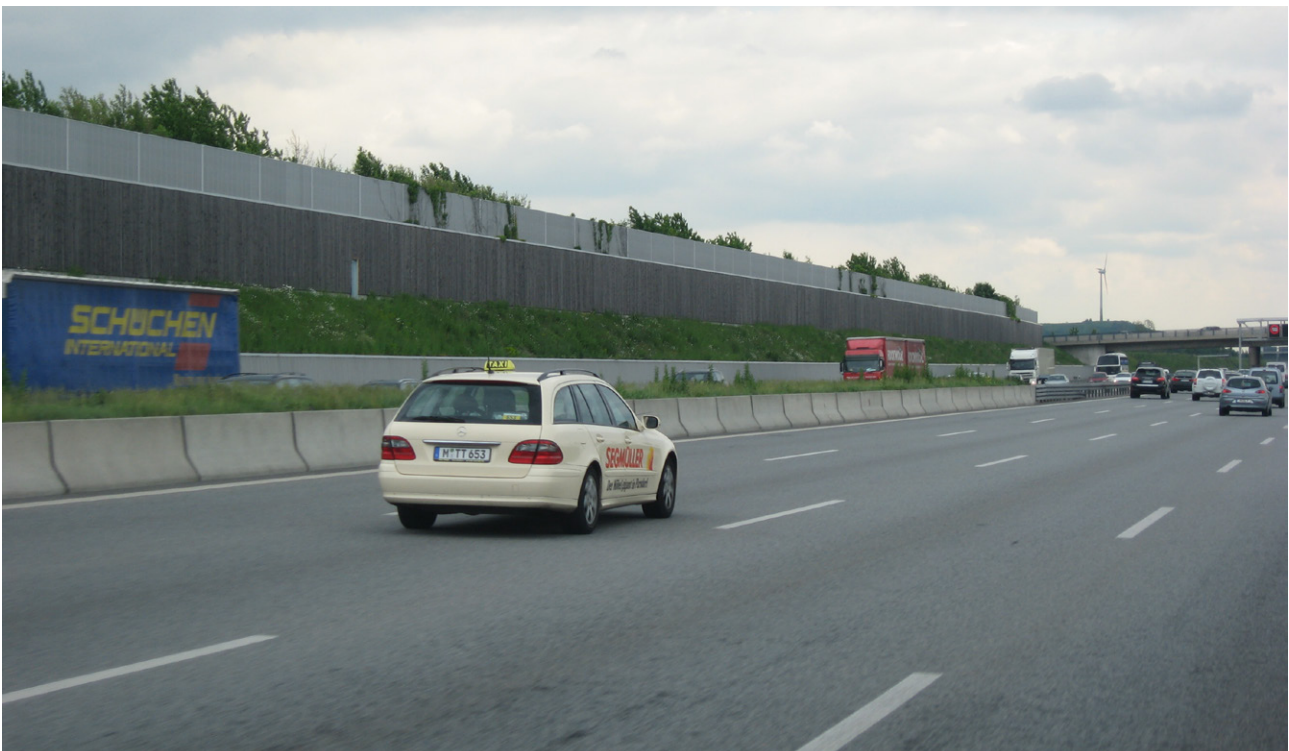
Figur 6.1: For at opnå en god støjreduktion er der på visse strækninger af motorvej A9 i Bayern anvendt både drænasfalt og støjskærme.
