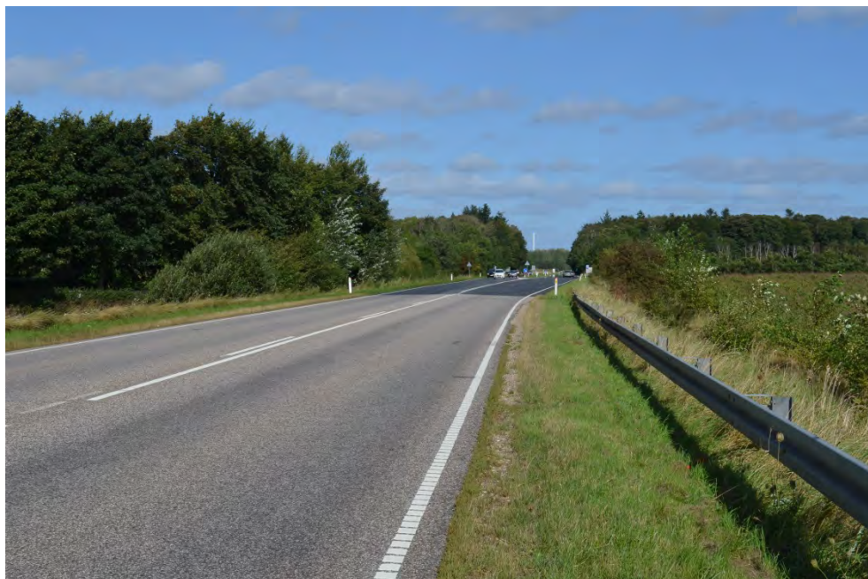
Figur 62 Landevejen set mod nord. Eksisterende forhold.
